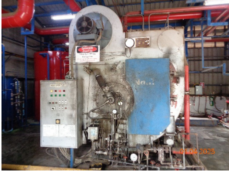
ภาพที่ 2-1 ระบบควบคุมกึ่งอัตโนมัติ ควบคุมส่วนผสมระหว่างอากาศและน้ำมันที่ Boiler
