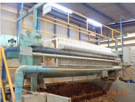
ภาพที่ 2-22 เครื่องอัดตะกอน จากระบบบำบัดน้ำเสีย
