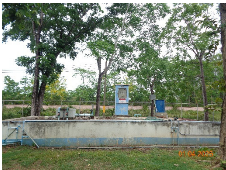
ภาพที่ 2-13 ระบบบำบัดน้ำเสีย แบบตะกอนเร่ง (AS)
